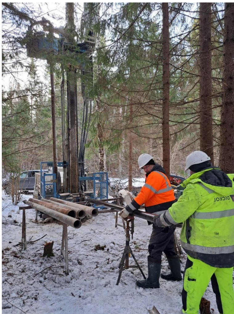
Foto 4.2. Puurtööd uuringuruumis 2023. a märtsis. Puuriti puurpingiga Massenza MI8 (PA-5); (foto E. Krjukova, 03.03.2023 N 59°13'30", E 25°10'27").
